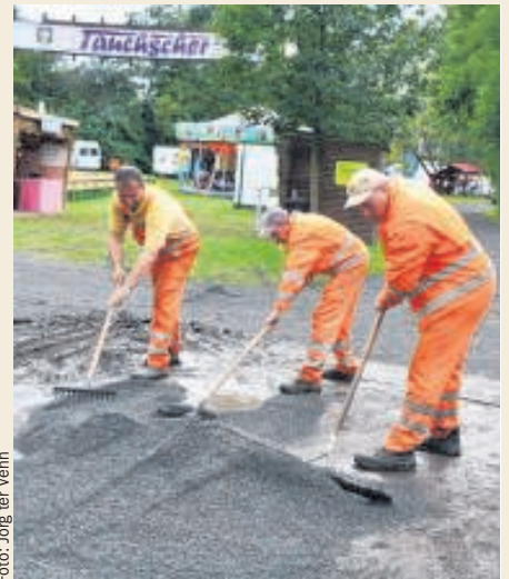
Tonnenweise Split verteilen die Männer des Bauhofes auf den Festwiese-Wegen.
